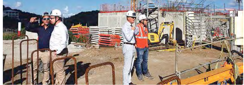
Visite de chantier de construction du collège 900 à la Savane en présence du préfet Vincent Berton et du secrétaire général Fabien Sésé.
